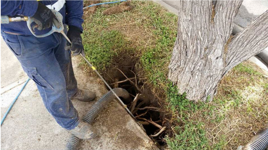
Εικόνα 8. Αποκάλυψη ριζών με αεροσυμπιεστή
